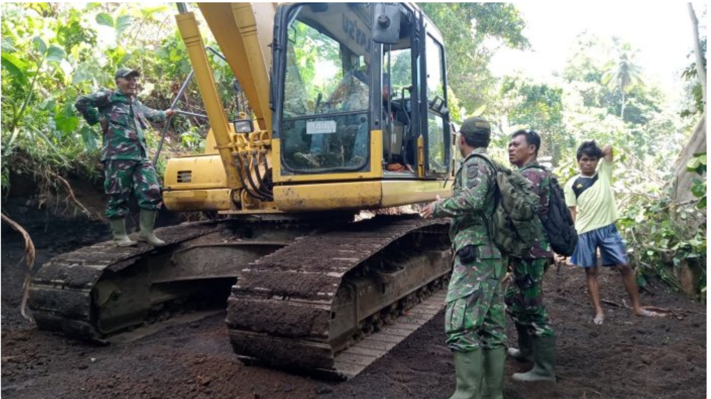
Ribtisan Jalan Pertanian pada TMMMD Ke-116 Tahun 2023 Kodim 1310 Bitung
