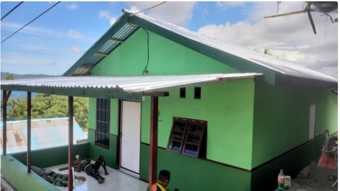
Renovasi RTLH TMMMD Ke-116 Kodim 1310 Bitung
